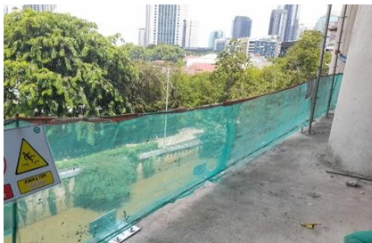
Gambar 3 – Foto penerapan safety net di proyek penelitian yang menunjukkan jaringan hanya dipasang sebagian.
