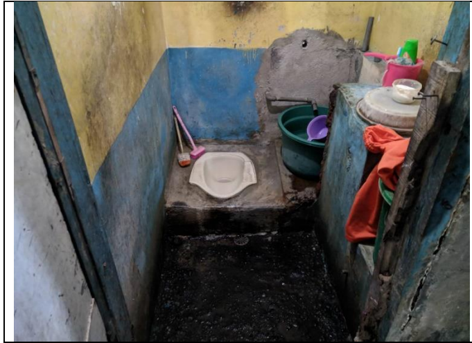
Kondisi Jamban Responden 2
