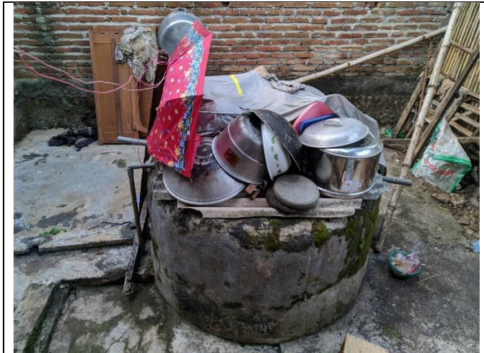
Kondisi Sumur (Mesin pompa air)
