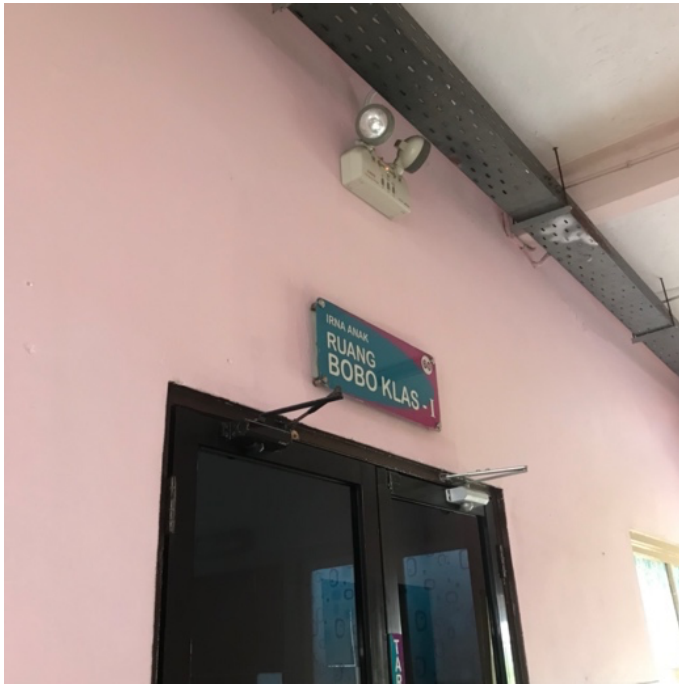
Gambar 4. Ruang Perawatan Bobo Kelas I
